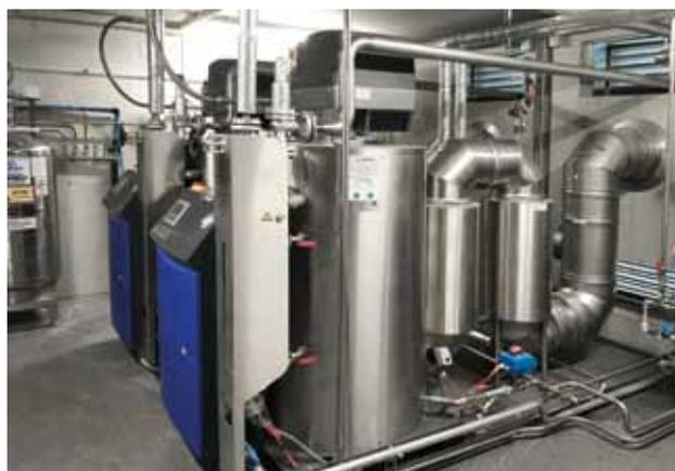
*Fig.: Instalación de vapor múltiple. Segundo economizador de JUMAG aguas abajo instalado en el bastidor de base para ahorrar espacio*
